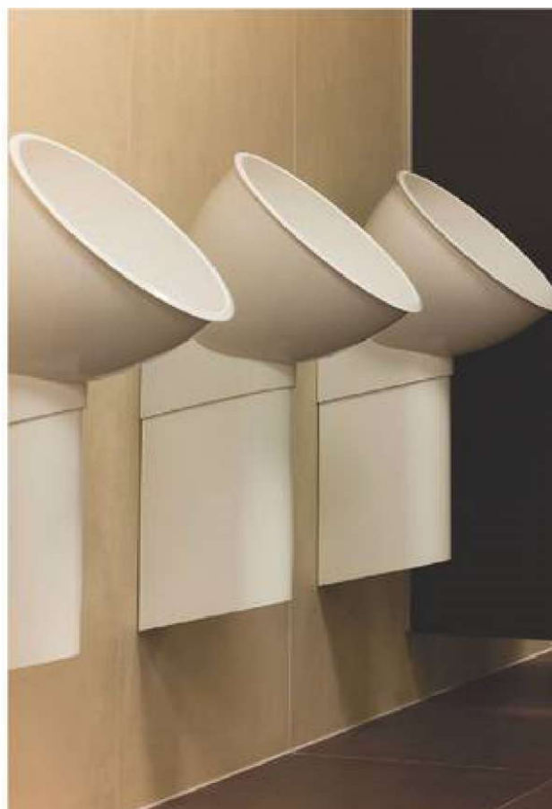
St. Jakobshalle, Basel
